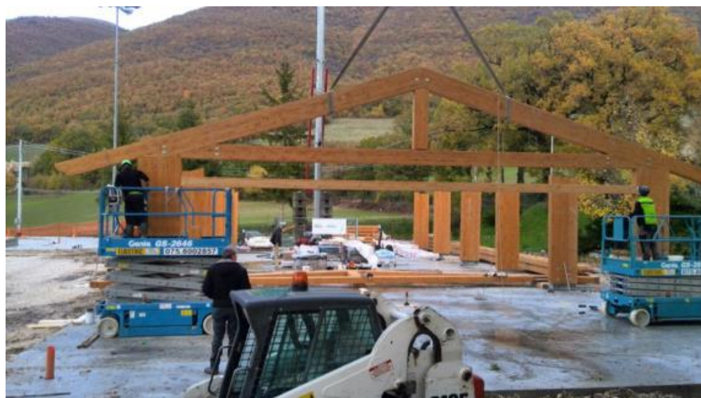
La Casa di Ancarano in costruzione
